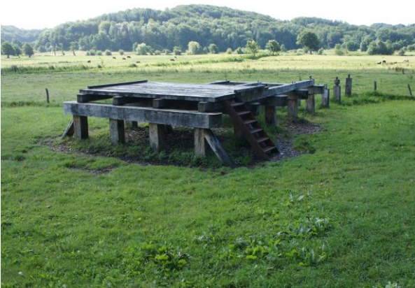
Fig. 12. Rekonstruktion af brofag (HA)
