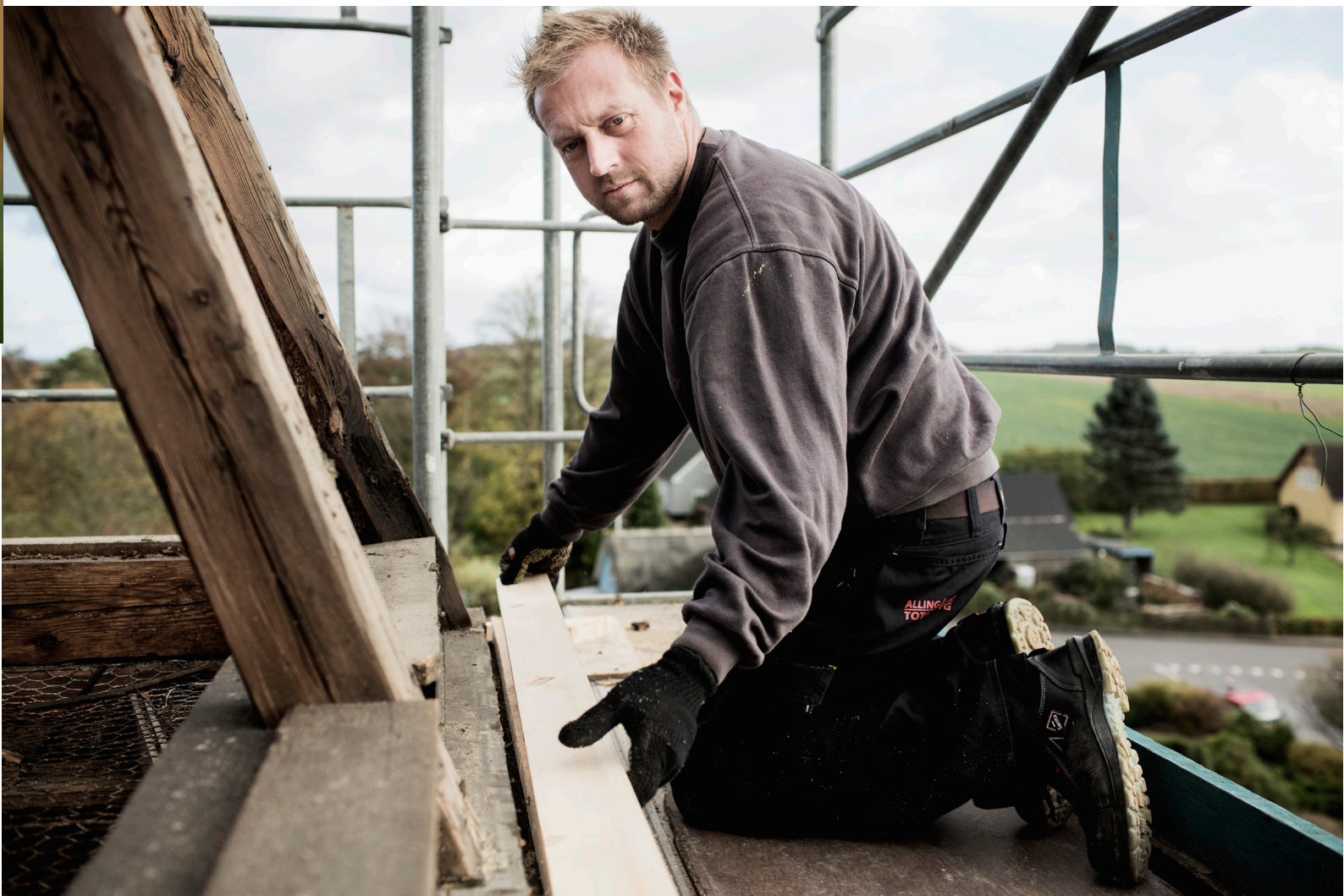
En tømrer renoverer tårnet på Fausing Kirke.
