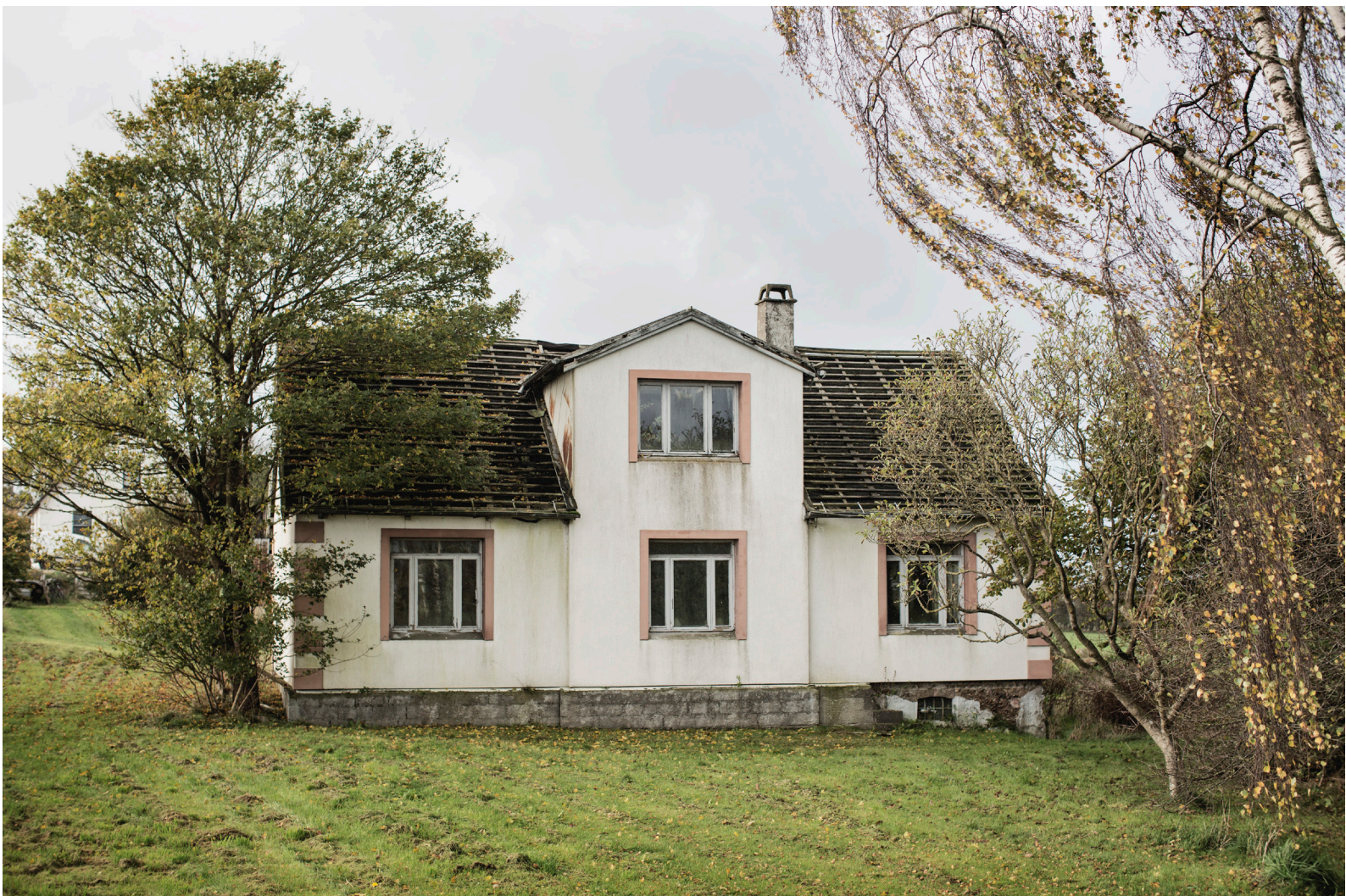
Forladt hus langs Grenåvej.
